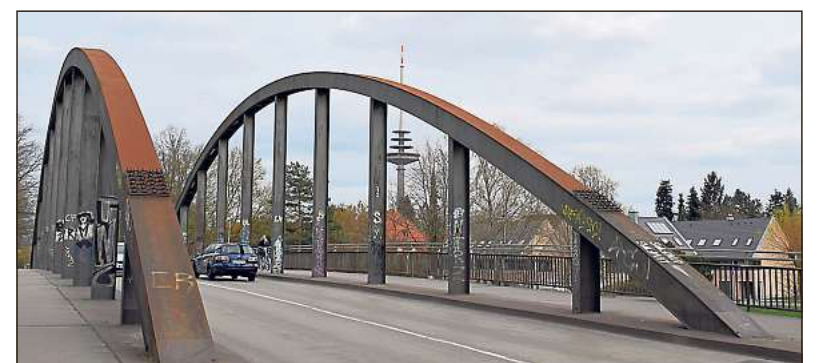
Die Kanalquerung über die Wolbecker Straße ist als Nächstes an der Reihe: Hier wird ab September zunächst eine neue Brücke errichtet, bevor die alte abgerissen wird.
