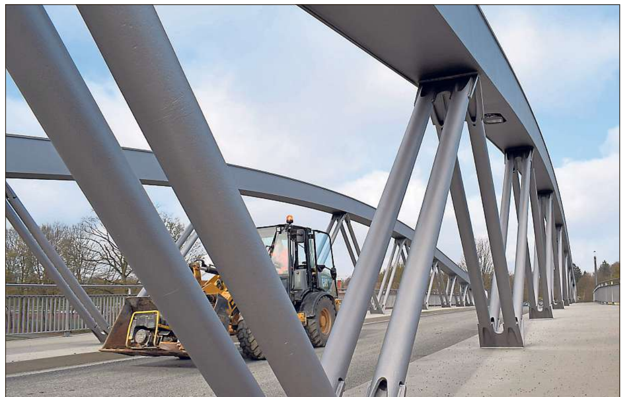
Letzte Fahrten für die Baumaschinen: Vom heutigen Donnerstag an ist die neue Laerer-Landweg-Brücke über den Dortmund-Ems-Kanal in Münster für den Verkehr freigegeben. Knapp zwei Jahre lang konnten hier nur Radfahrer und Fußgänger über eine Behelfsbrücke die Wasserstraße queren. Bilder: Zinke
